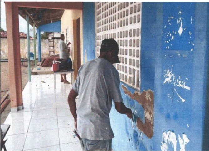
FOTO 03 - DEMOLIÇÃO DE REBOCO
