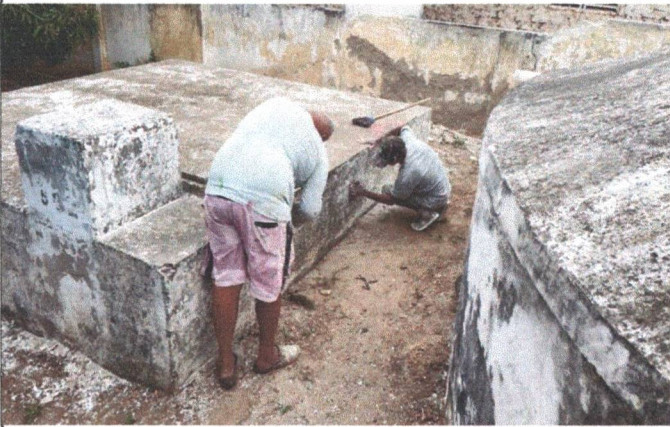
FOTO 01 - REMOÇÃO DE PINTURA
