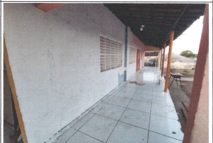
FOTO 12 - APLICAÇÃO DE MASSA CORRIDA
