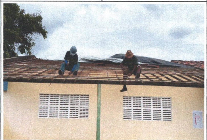
FOTO 10 - REVISÃO DE COBERTA
