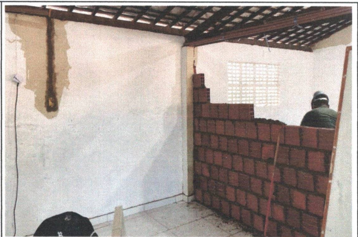
FOTO 08 - ELEVÇÃO DE ALVENARIA
