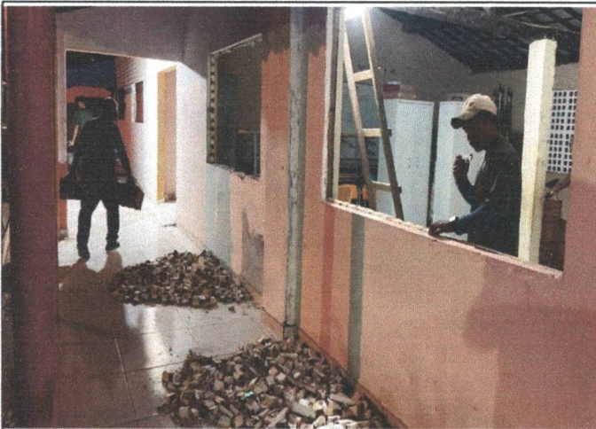
FOTO 07 - DEMOLIÇÃO DOS COBOGÓS
