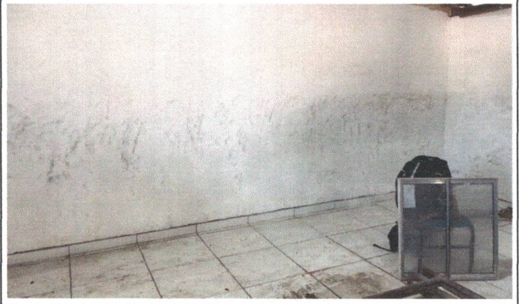
FOTO 02 - REMOÇÃO DE PINTURA
