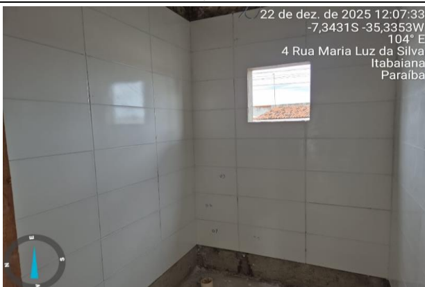
FOTO 04 Execução do Revestimento
