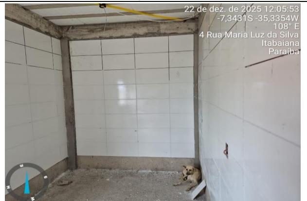
FOTO 05 Execução do Revestimento
