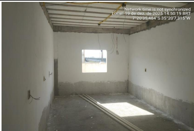
FOTO 02 Execução do Revestimento
