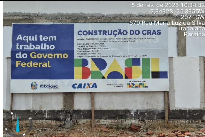
FOTO 01 Placa da Obra no CRAS
