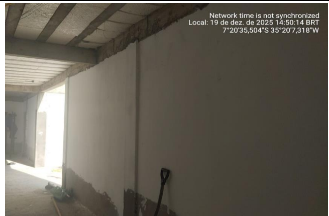
FOTO 03 Execução do Revestimento
