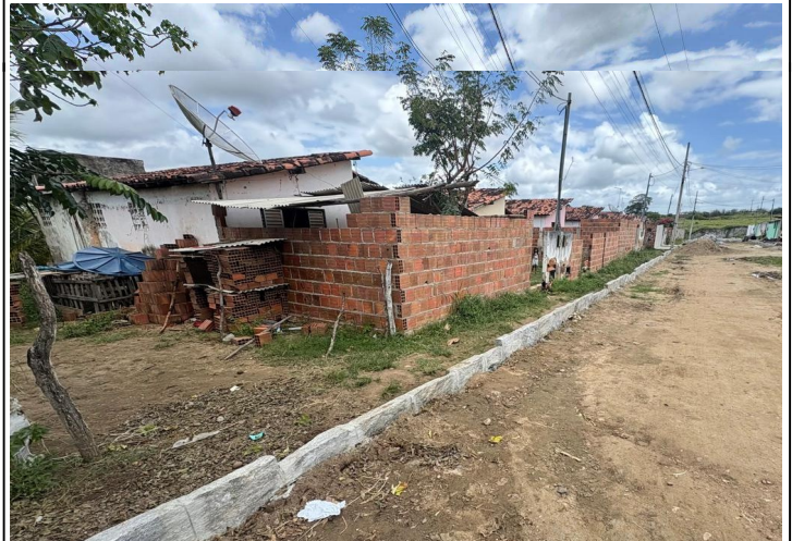
FOTO 04 - EXECUÇÃO DO MEIO-FIO
