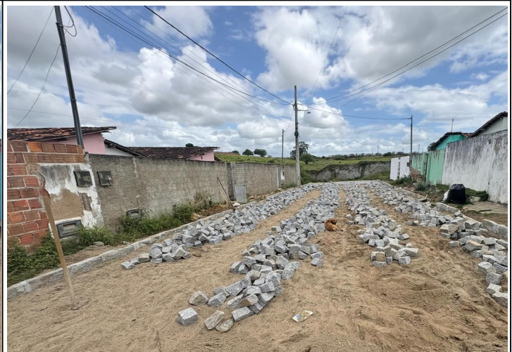
FOTO 06 - EXECUÇÃO PAVIMENTAÇÃO
