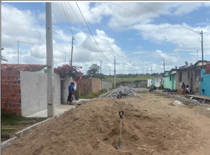
FOTO 05 - EXECUÇÃO DA PAVIMENTAÇÃO
