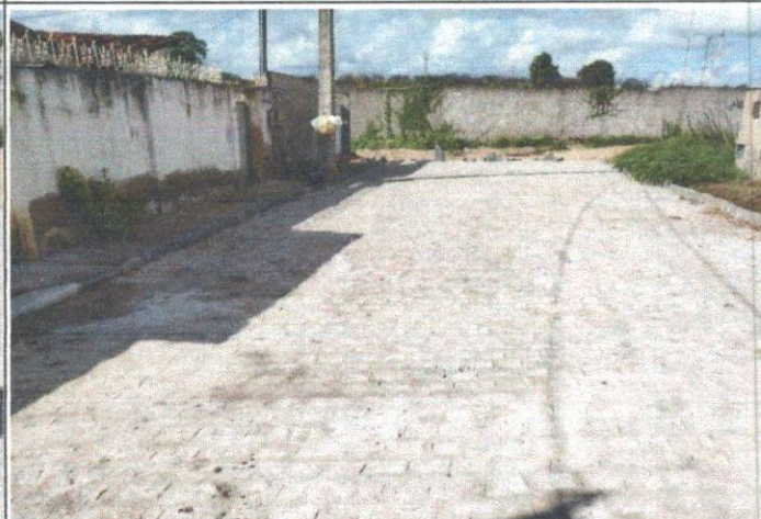
FOTO 10 - CONCLUSÃO DA PAVIMENTAÇÃO
