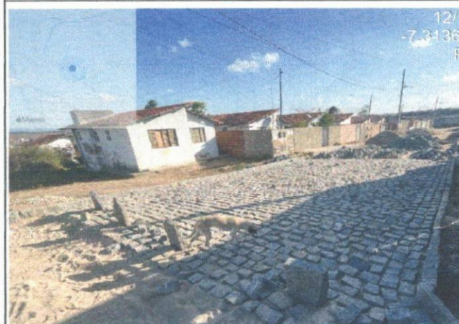
FOTO 05 - EXECUÇÃO DA PAVIMENTAÇÃO
