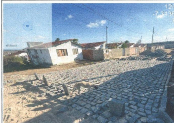
FOTO 05 - EXECUÇÃO DA PAVIMENTAÇÃO
