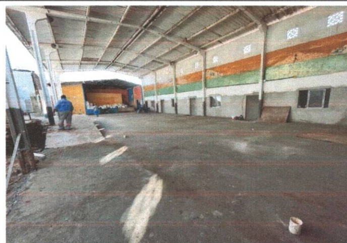
FOTO 06 - ALVENARIA Maria Cristina Gonçalves de Carvalho Engenheira Civil CREA-PB Nº 161955-1/13
