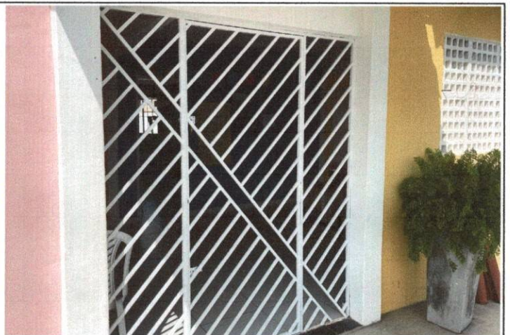
FOTO 08 - PINTURA ESQUADRIA METÁLICA
