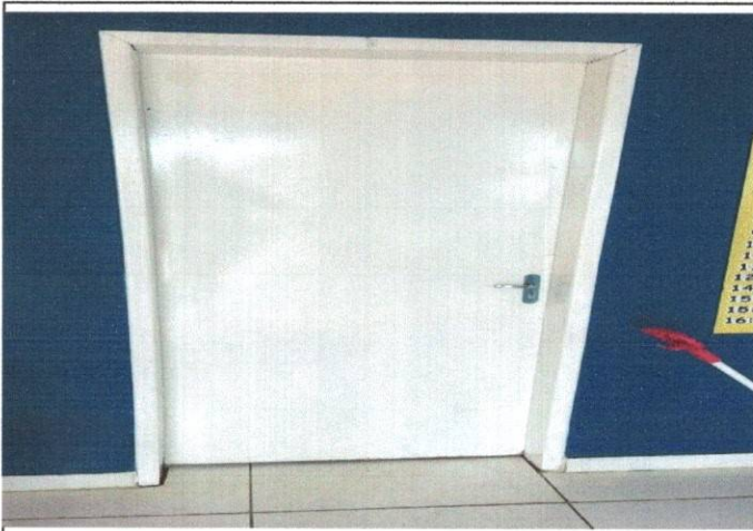
FOTO 07 - PINTURA ESQUADRIA DE MADEIRA
