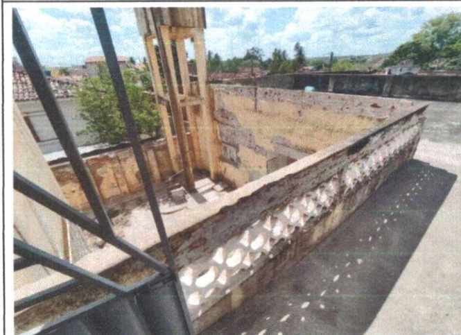
FOTO 05 - DEMOLIÇÃO DO REBOCO
