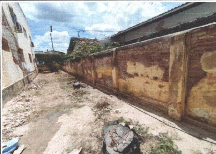
FOTO 04 - DEMOLIÇÃO DO REBOCO
