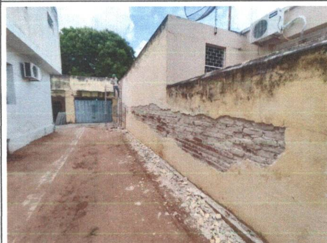
FOTO 03 - DEMOLIÇÃO DO REBOCO
