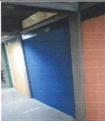
FOTO 03 Execução de Pintura Interna
