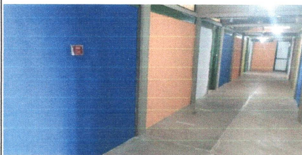
FOTO 01 Execução de Pintura Interna
