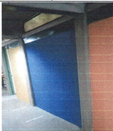
FOTO 03 Execução de Pintura Interna
