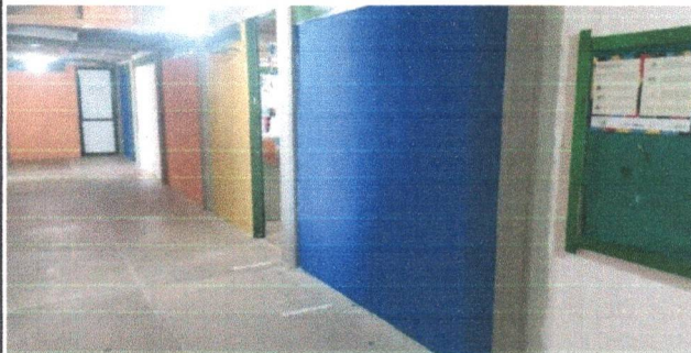
FOTO 02 Execução de Pintura Interna
