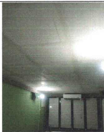
FOTO 06 Execução de Forro de Gesso
