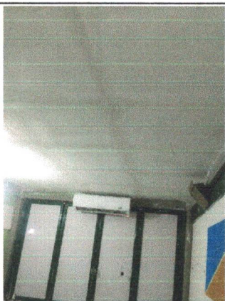
FOTO 05 Execução de Forro de Gesso
