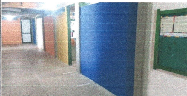
FOTO 02 Execução de Pintura Interna
