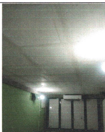
FOTO 06 Execução de Forro de Gesso
