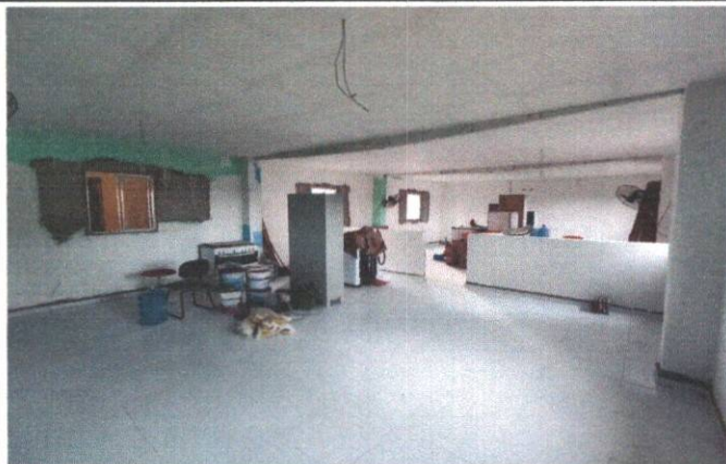
FOTO 01 - FORRO DE GESSO
