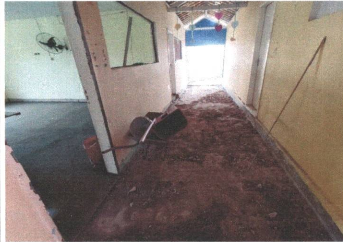
FOTO 04 - DEMOLIÇÃO DO CONTRAPISO
