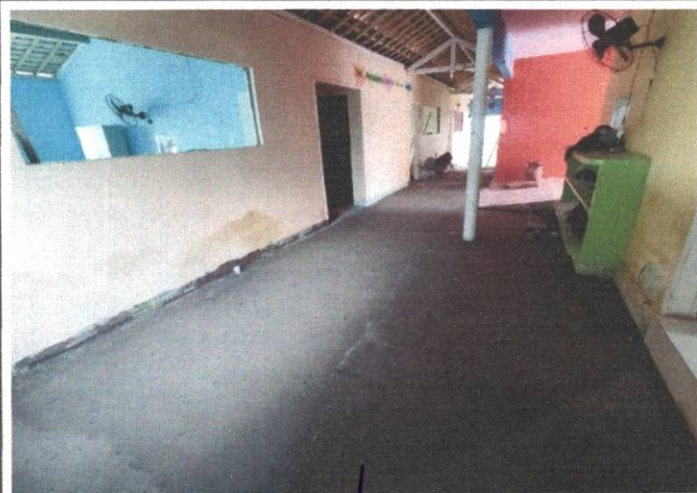
FOTO 06 - EXECUÇÃO DO NOVO CONTRAPISO
