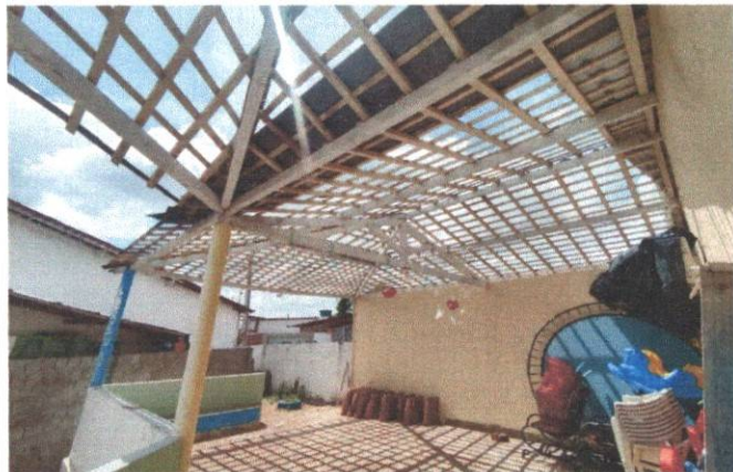
FOTO 01 - REVISÃO DA COBERTA
